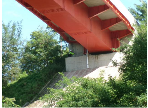
도보를 이용한 외관조사
